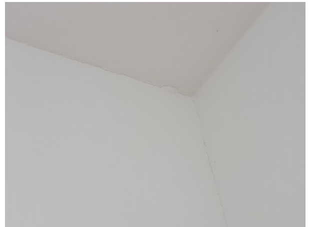
Innendispersion Risse Übergang Trockenbau zu Massivwand
